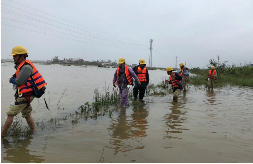
Hỗ trợ tại Quảng Ngãi, đội xung kích Công ty Truyền tải điện 3 trên đường triển khai nhiệm vụ căng lại đường dây 110kV qua huyện Mộ Đức, chiều 30/10
